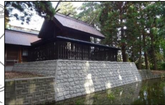
大館神社（本殿玉垣改修完成）
