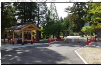
大館神社（手水舎改修・曳山車通路完成）
