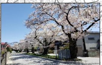
桜並木通り（幸町地区）植樹帯・路側側溝・街路樹整備 電線類統合・路面美化完成
